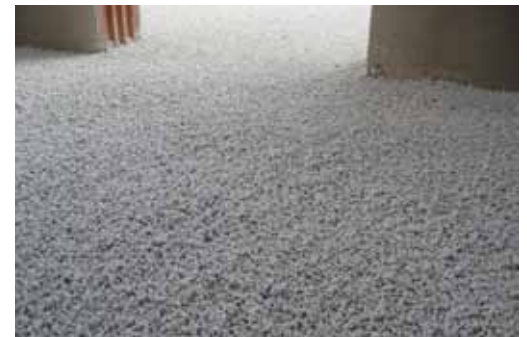
GEOCELL Blähglas gebunden mit mineralischem Binder
