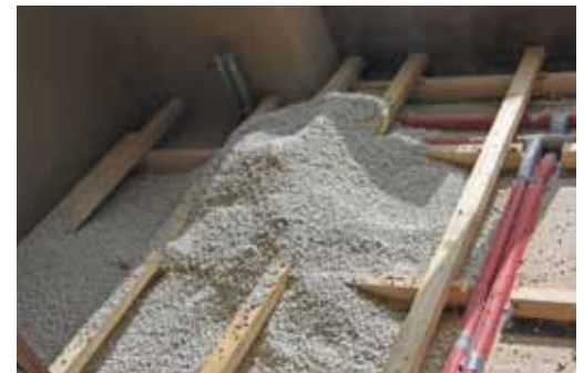
Einfach schütten und verfüllen
